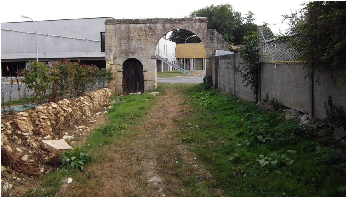
Le vieux porche de la ferme du Pavillon à Ouistreham (XVIII ème siècle), en août 2012 (©.HistoriCités).
